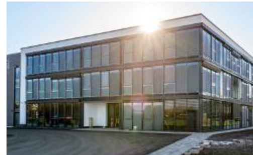
Zentrale der Karadag GmbH im Stadtteil Porz-Wahn.
