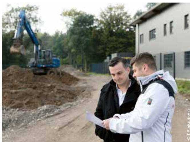
Sascha Maschinski (l.) vom KölnBusiness-Unternehmensservice und Stanislaw Parylak auf der Baustelle in Rath-Heumar.
