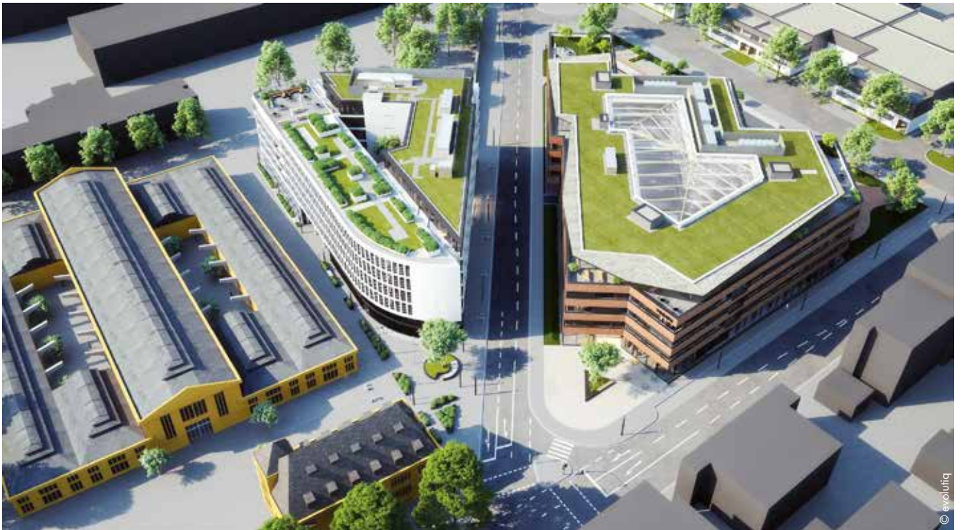
Lage und Grundriss: Das Vorum liegt an der Vitalisstraße in Köln-Ehrenfeld vis à vis zu THE SHIP, weiter links befindet sich die Alte Wagenfabrik.
