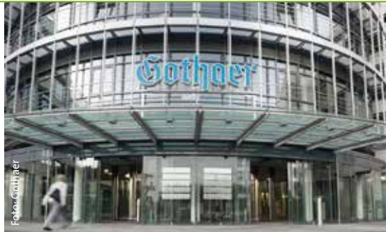
Die Hauptverwaltung der Gothaer in Köln-Zollstock – hier der Eingang – gilt seit diesem Jahr als klimaneutral.
